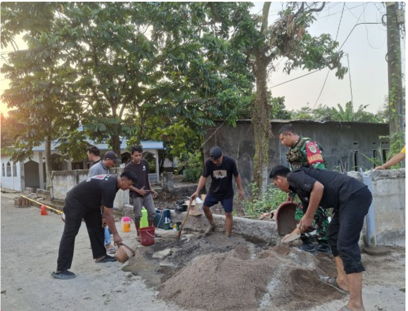
Pembuatan patok portal perlindungan kereta api jalan galur desa Cibening Purwakarta
